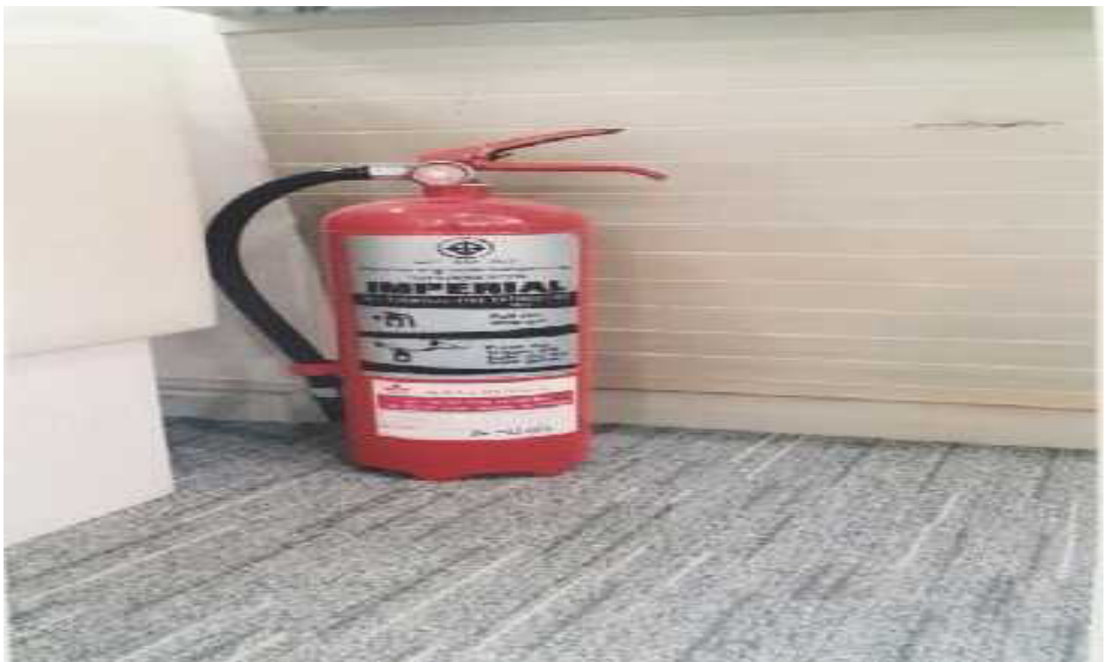
14. อุปกรณ์สำหรับดับเพลิง
